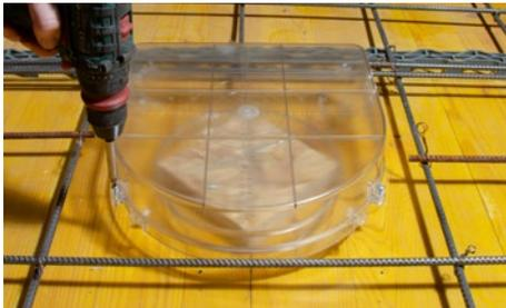
**3.** Gehäuseoberteil montieren. Befestigung mittels vier Schrauben.
