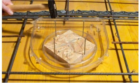
**2.** Gehäuseunterteil ausrichten und mit vier Nägel befestigen. (Nägel dürfen nur soweit eingeschlagen werden, bis diese bündig auf dem Gehäuseunterteil aufliegen)
