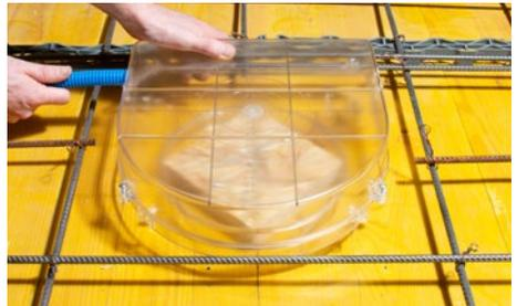
**4.** Rohrverbindungen erstellen. (Rohreinführungen vorsichtig ausbrechen)
