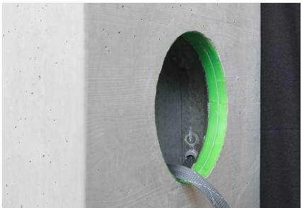
**5.** Une fois le béton séché et le moulage retiré :
